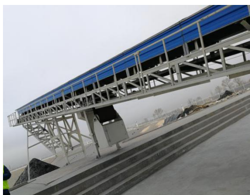
固化物输送廊道
