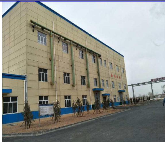
固化车间废气集气管道
