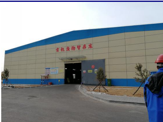
有机废物暂存库
