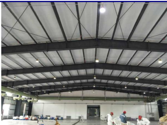
暂存库集气管道
